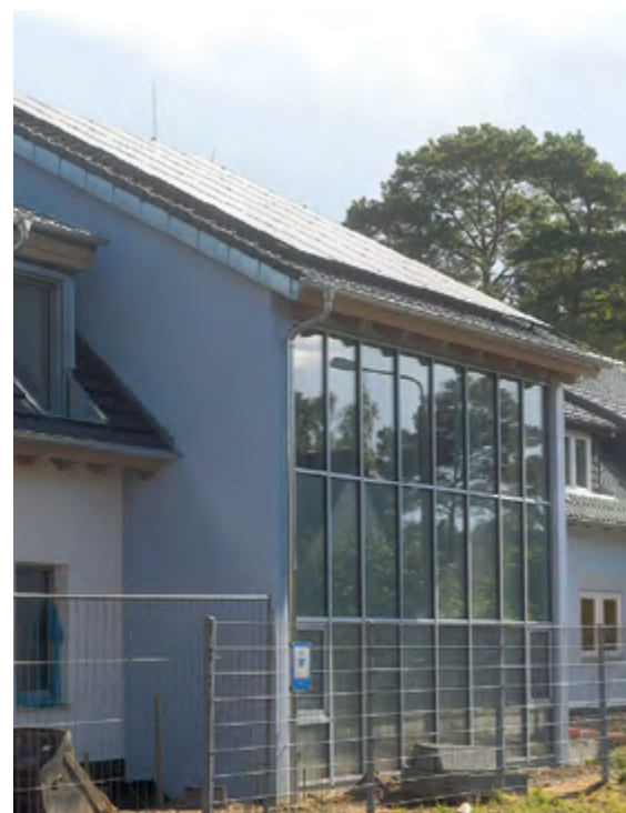
31.08.26: Der Erweiterungsbau ist startklar.
