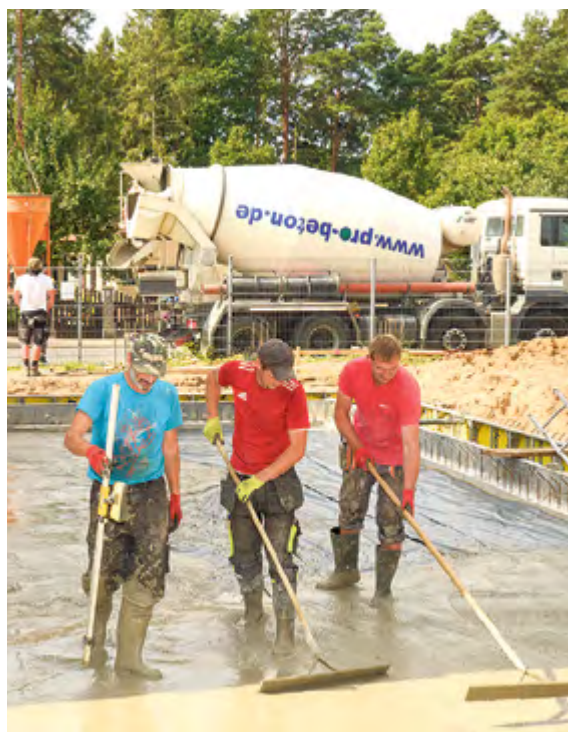
13.08.25: Das Fundament wird gegossen.
