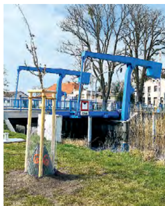
Hubbrücke am „Langen Trödel“.
