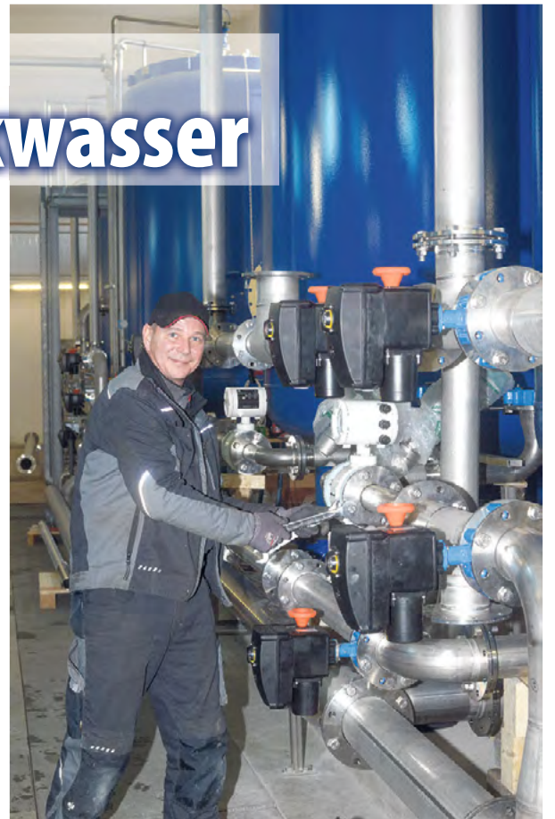
▲ Aus mehr als 400 Düsen wird mit Hochdruck Wasser und Luft in den Kessel gedrückt, um den Filter zu reinigen.
