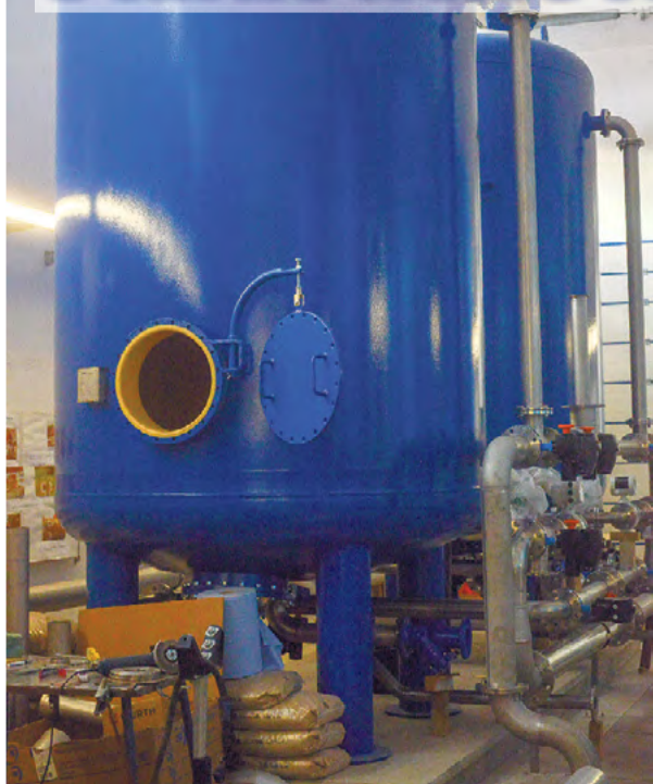
▲ Aus mehr als 400 Düsen wird mit Hochdruck Wasser und Luft in den Kessel gedrückt, um den Filter zu reinigen.
