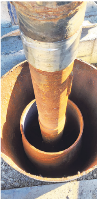
Ein neuer Brunnen wird gebohrt.
