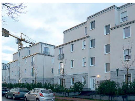
Im neuen Wohnpark sind 66 Wohnungen entstanden.
