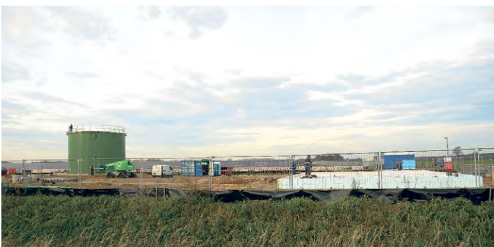
Die Bauarbeiten der Wasserstoff-Fabrik gehen zügig voran. Fotos (2): SPREE-PR/Krone
