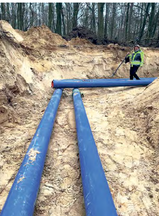
Den Verlauf der neuen Rohwasserleitungen hat Daniela Donner bestimmt. Foto: NWA
